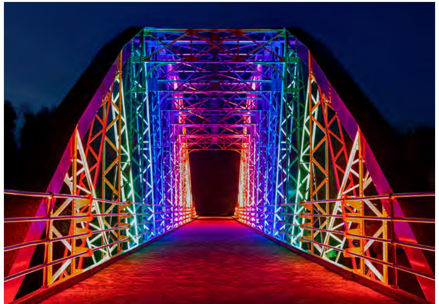
Puente de los Remedios, Villafranca de Cordoba 2022
